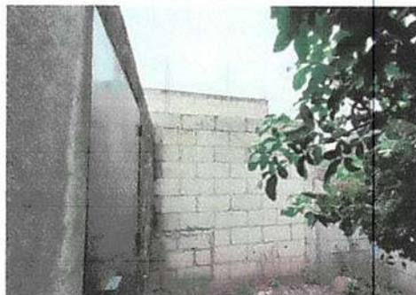
Foto 2: se necesita instalar base para colocar rotoplas de 10 toneles
