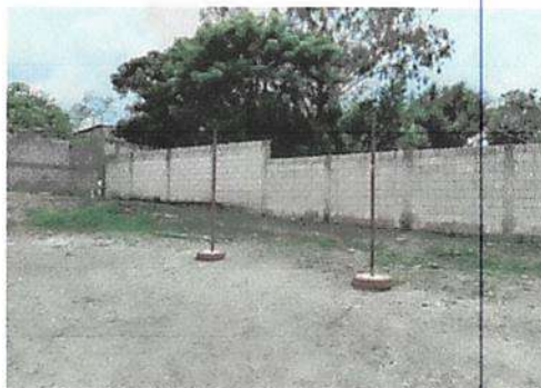
Foto 4: muro que pertenece al vecino.
